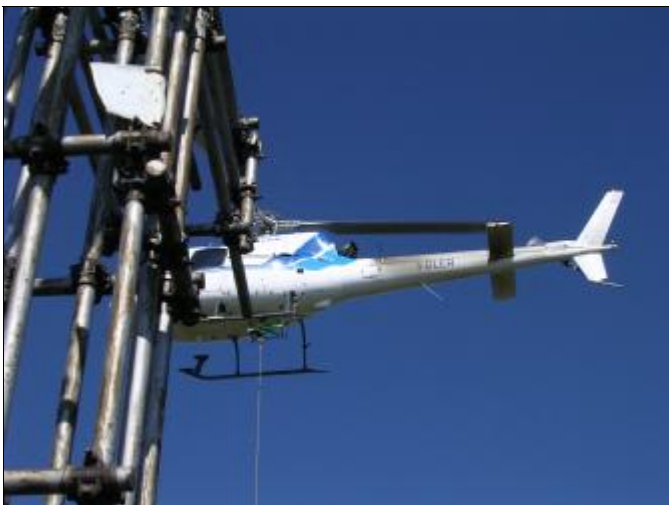
L'elicottero a pochi metri dalla croce sta posando il materiale necessario
